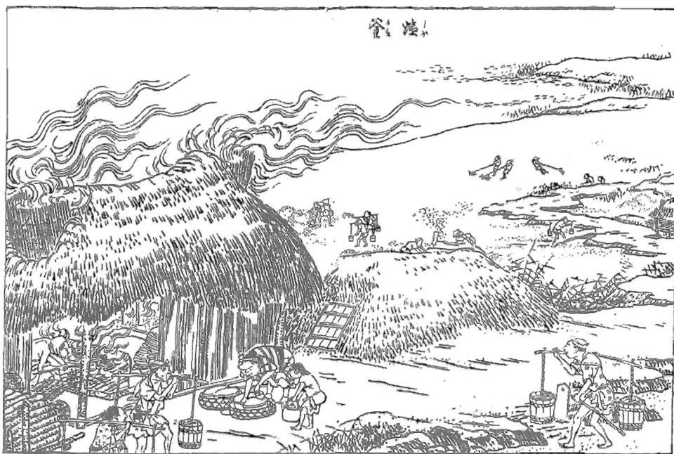
塩釜は薪焚き、竈屋1軒前の塩浜は7、8反。
