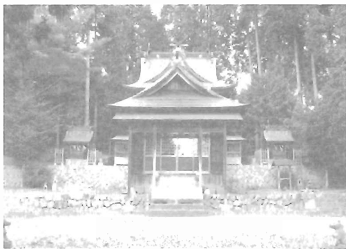
写真一 木野山神社奥宮(高梁市津川)
