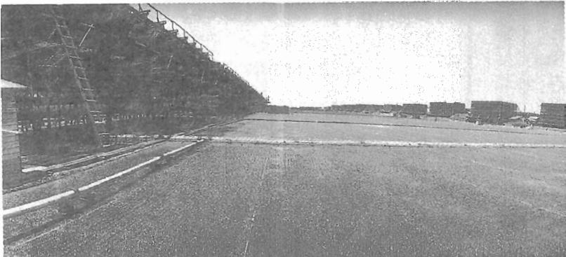
写真二 流下式塩田と枝条架（1955＝昭和30年頃）
