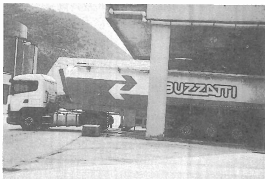
[サイロからの払出しを待つ散塩トラック]
