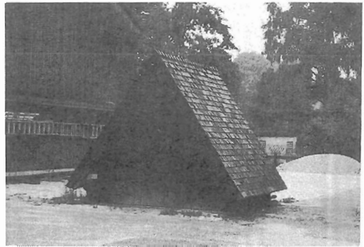
[工場構内 かん水取水口]
