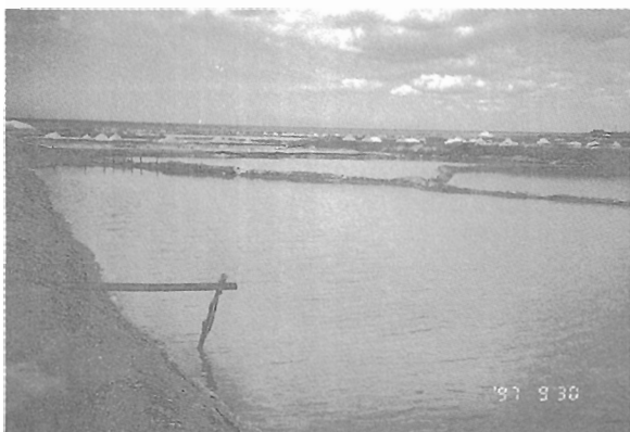
写真8 海水導入管と蒸発池
