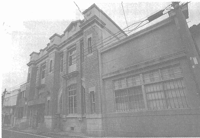
うすくち醤油資料館の外観
