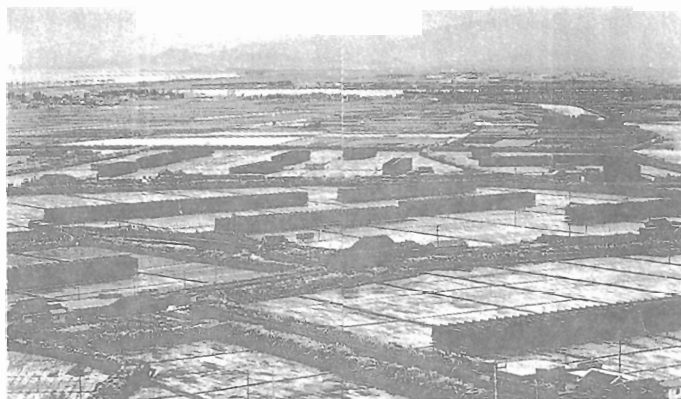
写真-2 流下式塩田 「鹽 写真集・鳴門塩田史」 鳴門塩業組合発行より
