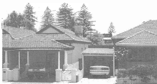
平屋建ての民家
