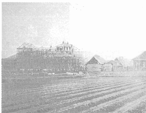
写真20 事務所建設当時の写真。 架上げ時のものと思われる。
