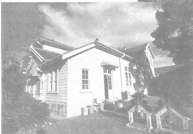
写真19 事務所裏側の全景。
