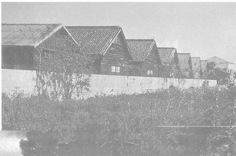
写真18 事務所に併設された塩保管倉庫群。
