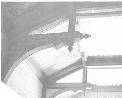
写真10 二階の天井を支えるハンマービーム。
