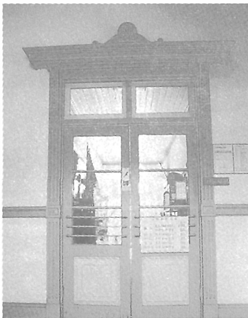
写真4 玄関内側の仕切り戸。 柱と桁に凝った装飾がある。
