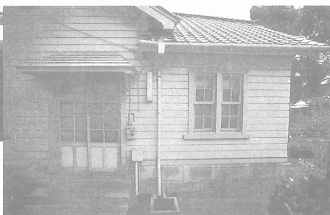
写真22 玄関横手の出入口。巡視の部屋があった。
