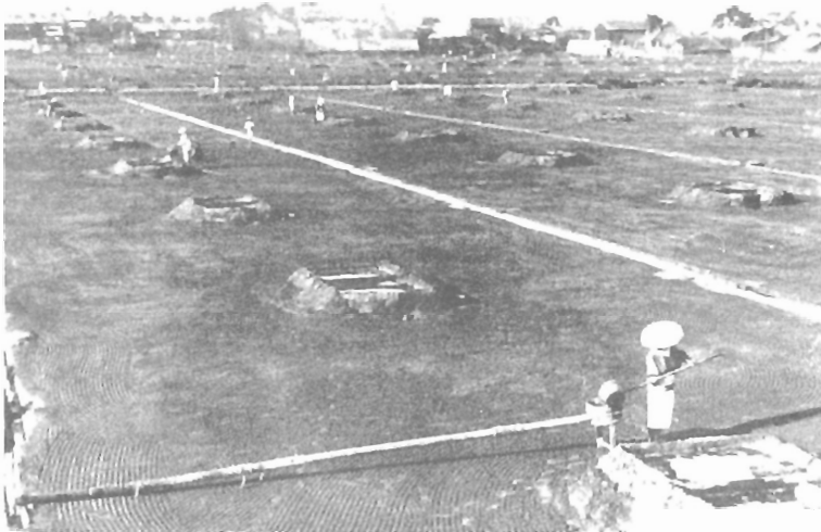
かん水輸送—移動式樋を使ってかん水を溝に流し込む。
