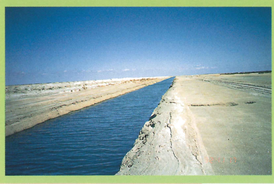
▼地下飽和かん水の集水溝
