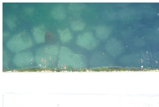
石巻湾(新設堤防付近) 海藻の付着が少ない
